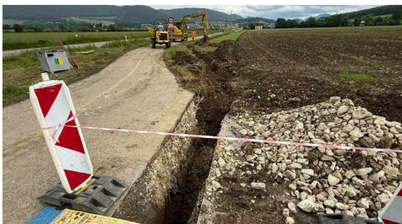
Travaux en cours | La réalisation de ce projet d'intérêt régional est pilotée par le SEVT. La ville de Delémont participe à son financement et sera co-proprétaire de la conduite.
